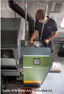
Quelle: KfW Bildarchiv / photothek.net Abb. Montage einer Holzpelletheizung
